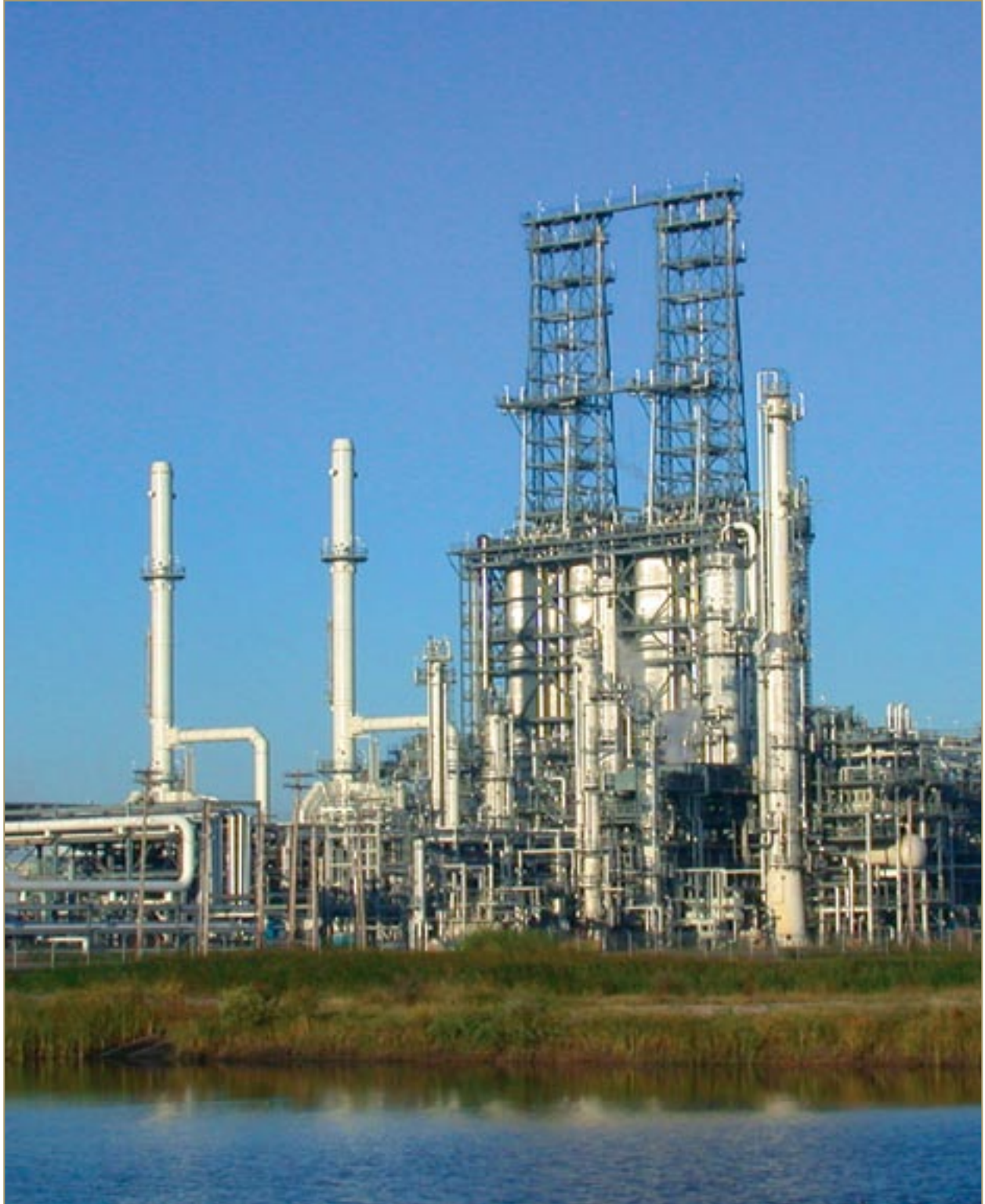
TEXAS CITY UNITÉ DE COKÉFACTION
